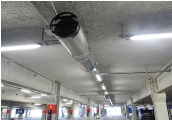
*Système d'optimisation des flux d'air dans les parcs de stationnement :Jetfan*
