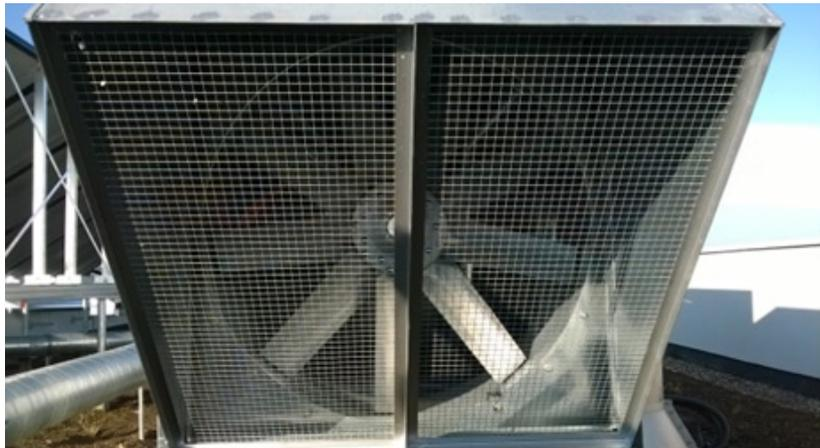
*Extraction mécanique : CHGT 1250 F400-120*
